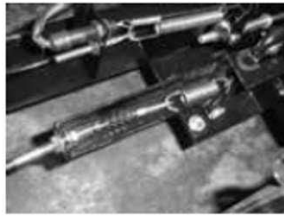
Conexión del cable en la parte delantera
